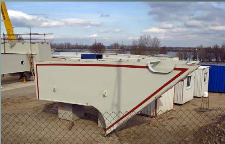
Most 2-3 (177 m): Zatega sa poprečnim nosačima.
